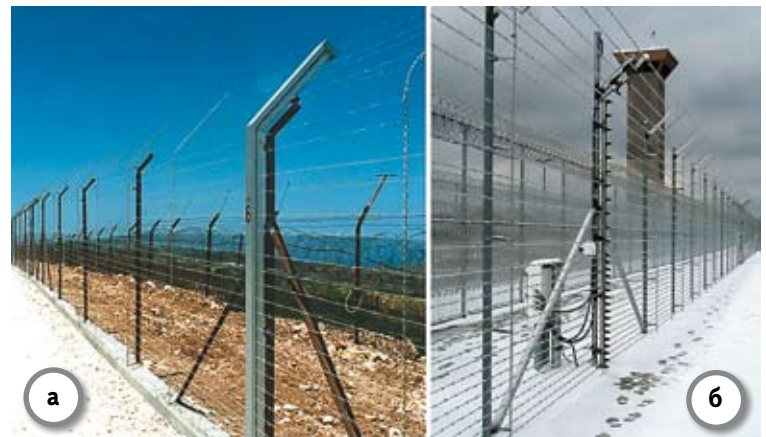
Рисунок 2. а) Полноростовое «прозрачное» ВСО YAEL с проволочным сигнализационным заграждением летом; б) ВСО DTR-2000 зимой
